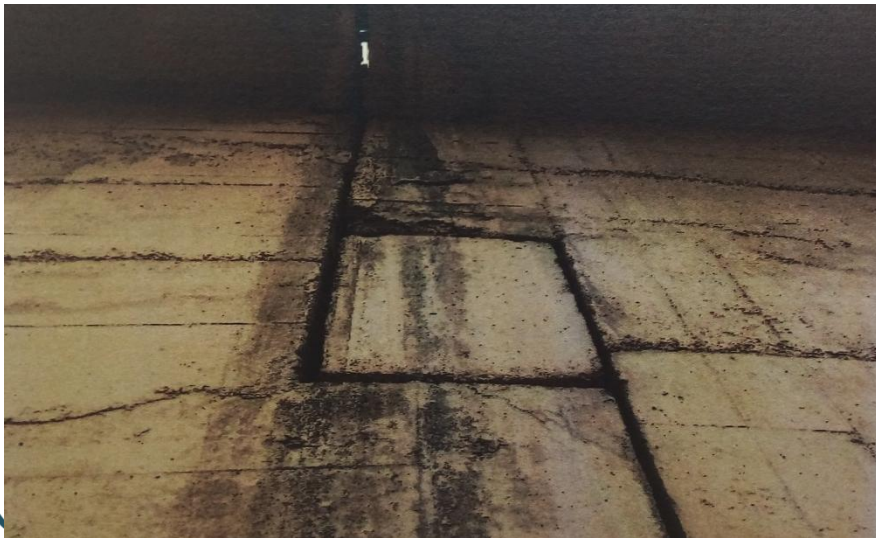
Rotules au niveau de la partie indépendante de la travée centrale
