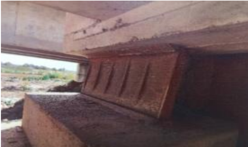
Appareil d'appui bloqué
